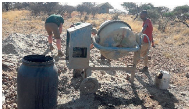
Слика 3. Поправљање појилишта (II) Figure 3. Repairing a waterhole (II)
