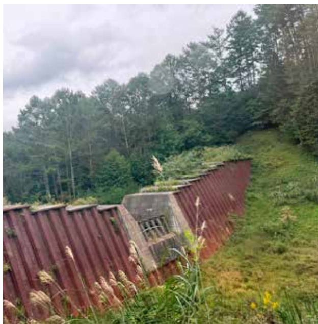
Слика 10. Слика бране за ублажавање последица клизишта, фотографија: аутор
