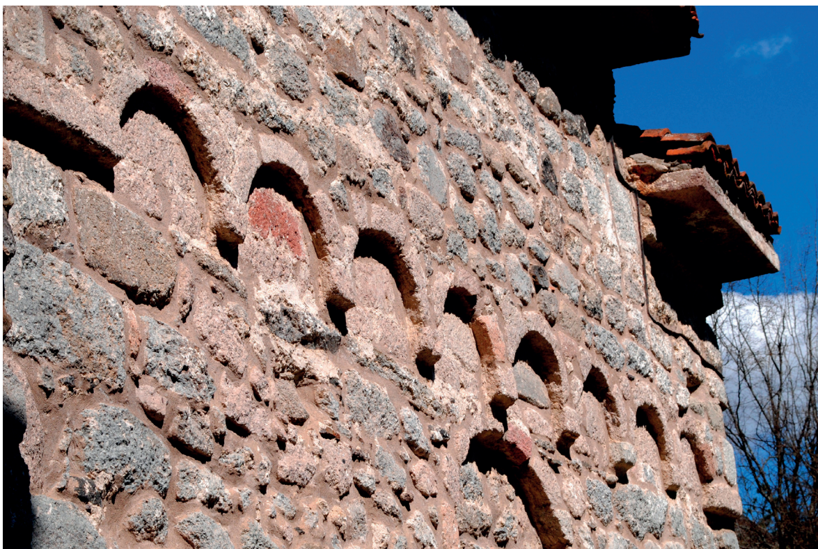
Слика 6. Фасада цркве Св. Арханђела Гаврила, фото: С. Белиј Figure 6: Facade of the Church of St. Archangel Gabriel, photo: S. Belij
